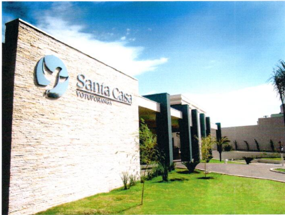
Figura 2 - "Santa Casa de Misericórdia de Votuporanga" em 2010
